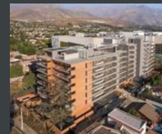
Edificio Río Guadiana 8745 Las Condes
