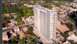
Edificio Vista Walker Martínez La Florida
