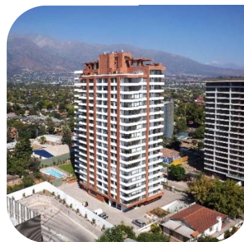
Edificio Ernesto Hevia
