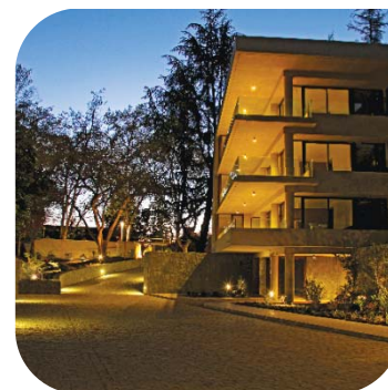
Edificio San Damián 404
