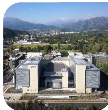
Ampliación Clínica Las Condes
