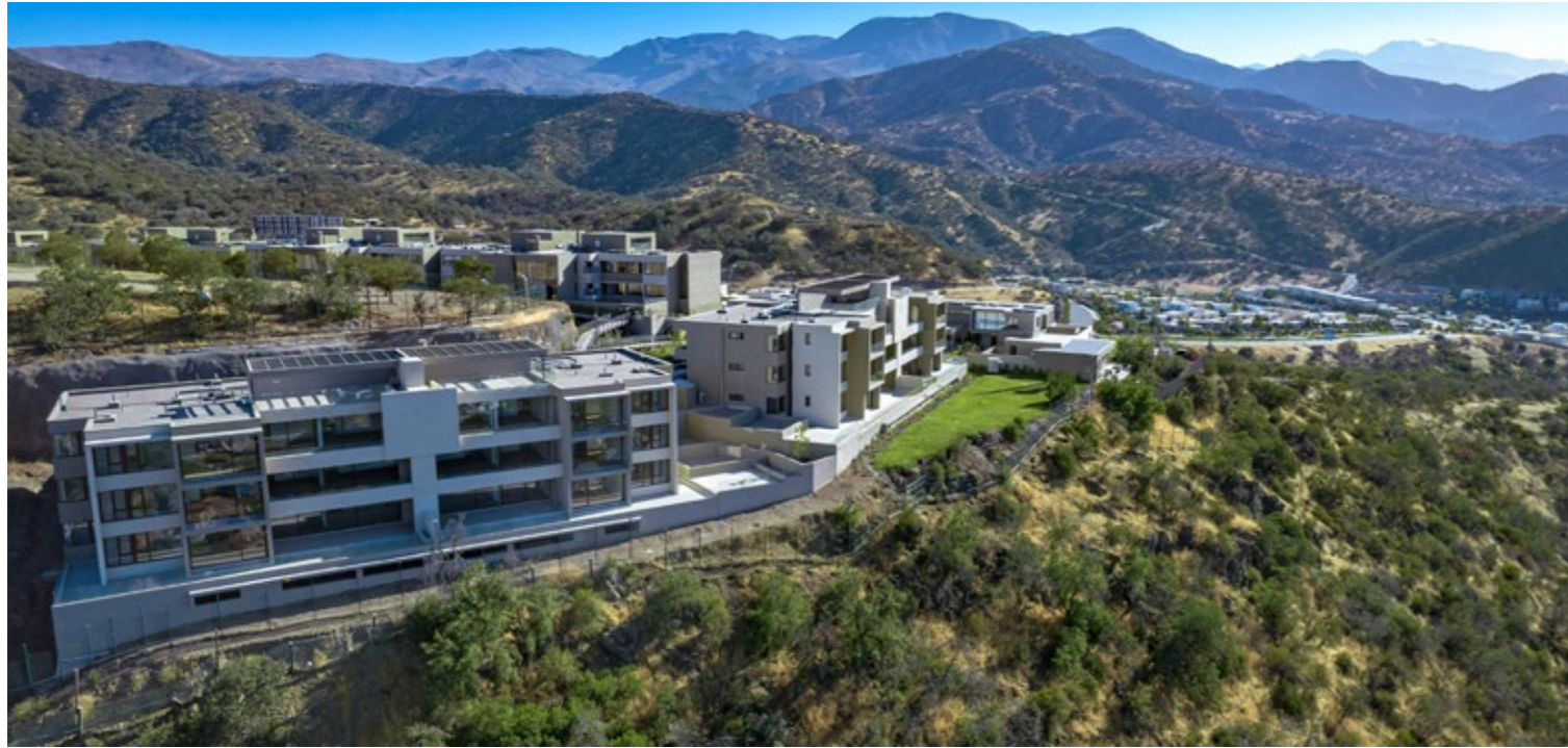
Edificios Mirador Los Trapenses, Lo Barnechea
