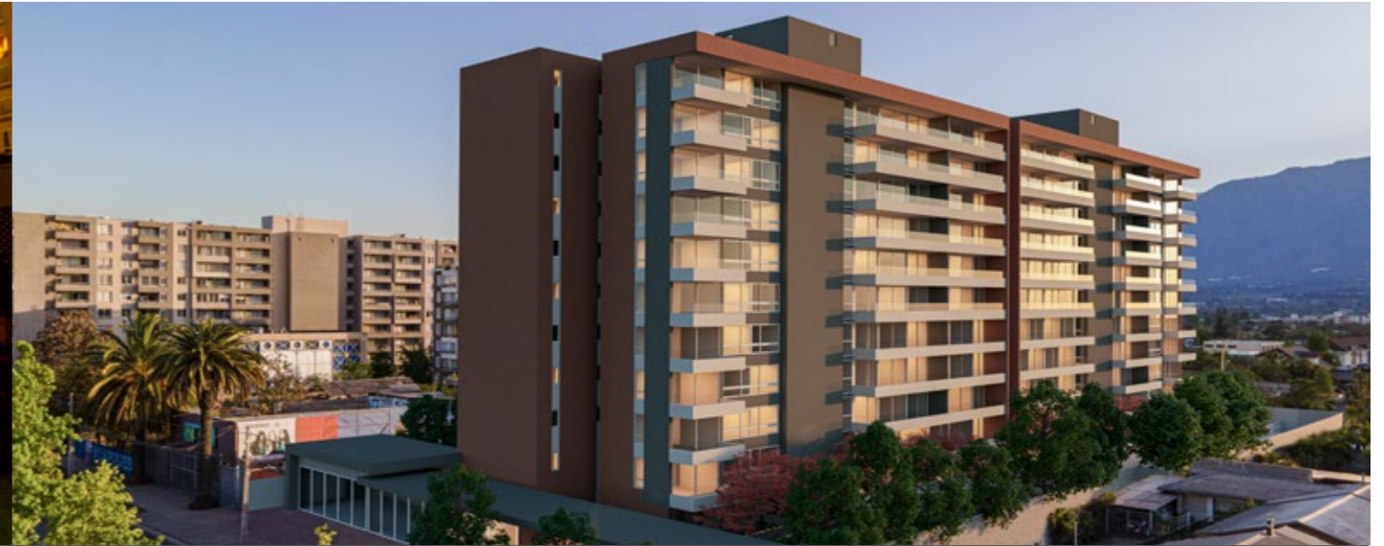
Edificio Vicuña Mackenna, La Florida
