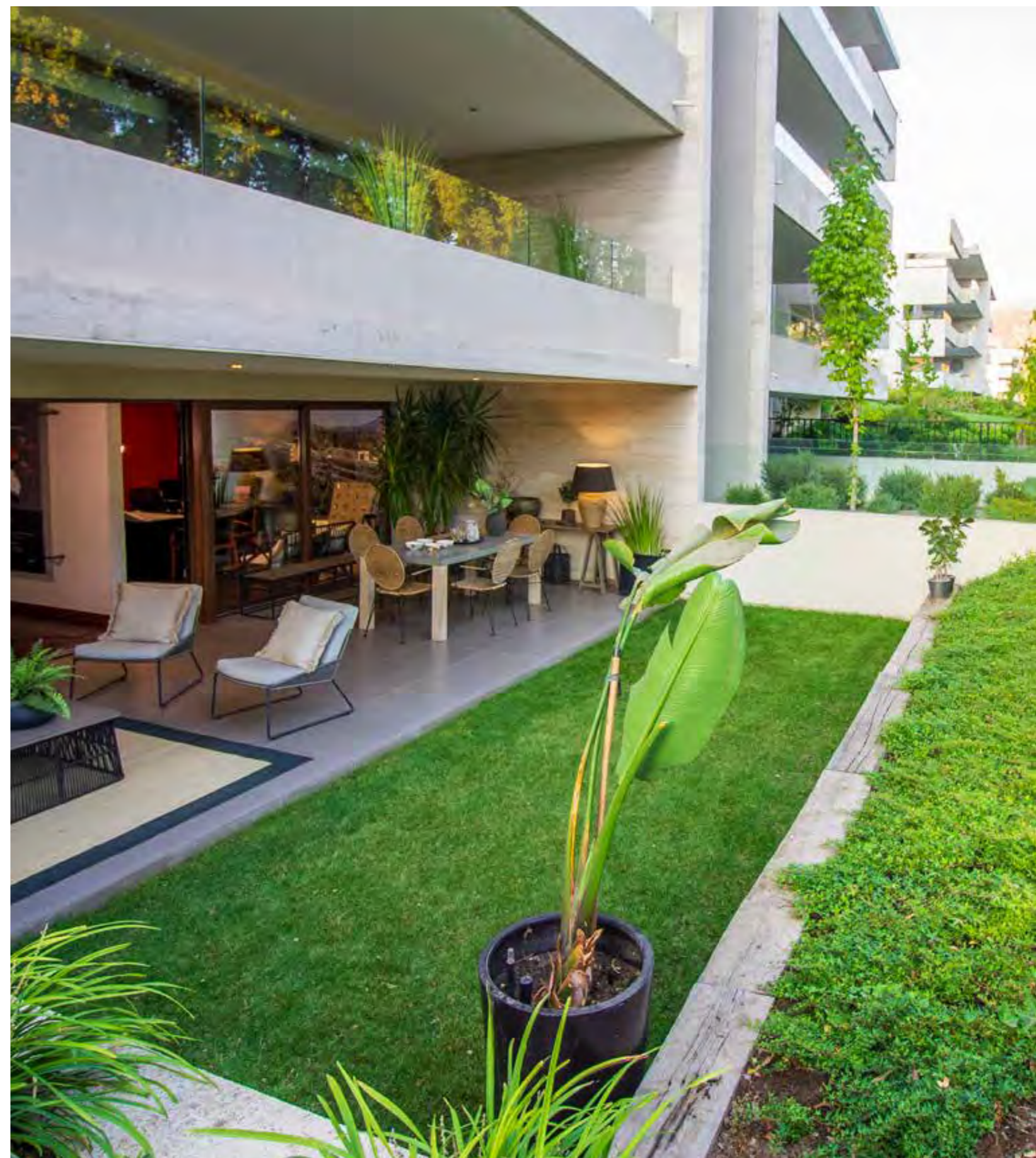
■ Edificios Nogales del Golf, Lo Barnechea
