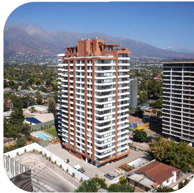
Edificio Ernesto Hevia
