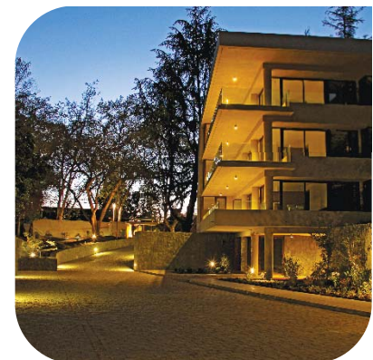
Edificio San Damián 404
