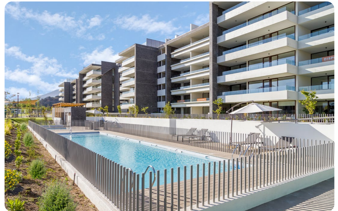
Edificios Parque Nogales, Lo Barnechea
