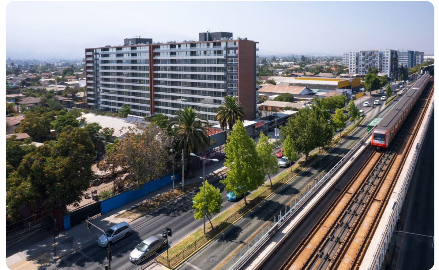
Edificio Vicuña Mackenna 8656, La Florida
