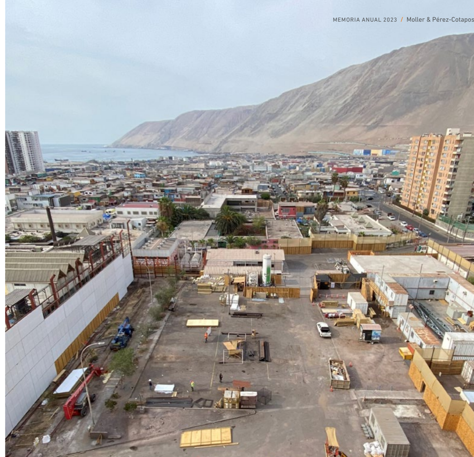
• Inicio obras Servicio de Oncología del Hospital Ernesto Torres Galdames, Iquique
