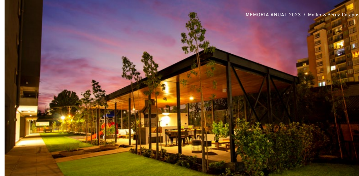
• Edificio Vista Walker Martínez, La Florida
