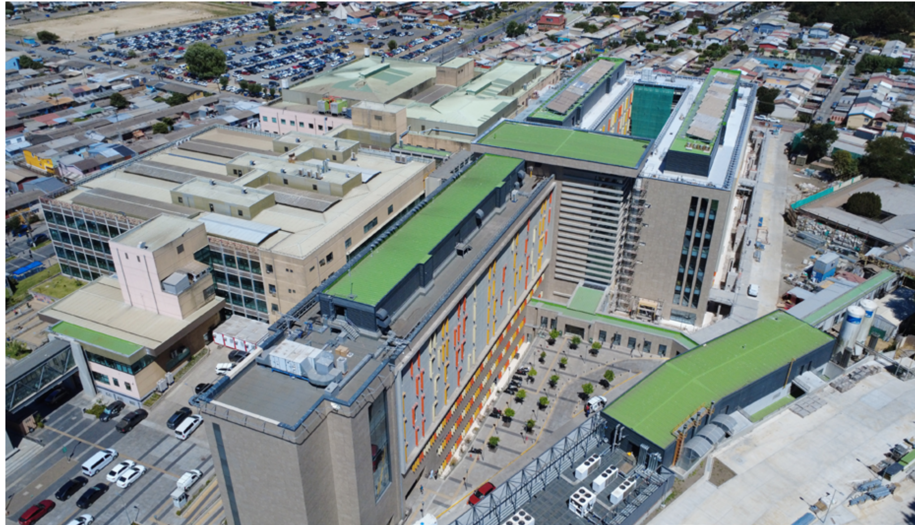
Construcción a Terceros, Hospital Higuera de Talcahuano etapa II
