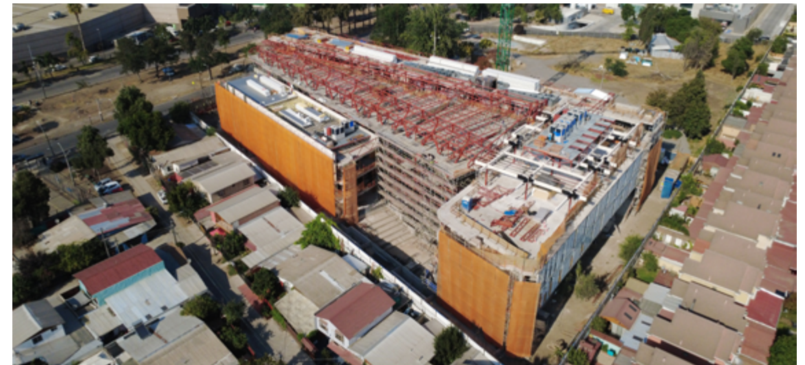
Construcción a Terceros, Ceca - Unab
